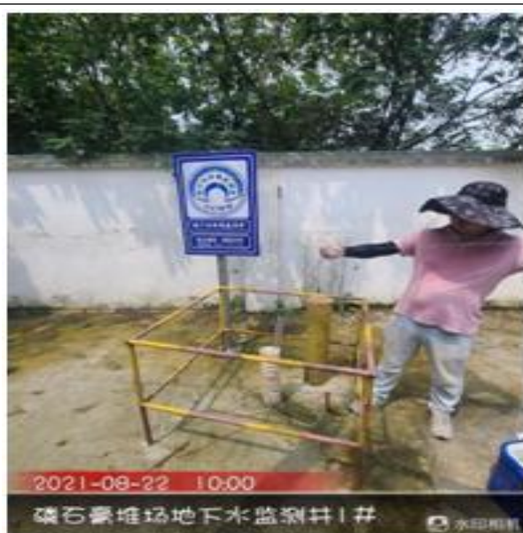
磷石膏堆场地下水监测井 1#
