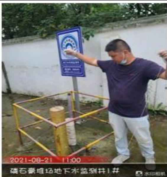
磷石膏堆场地下水监测井 1#
